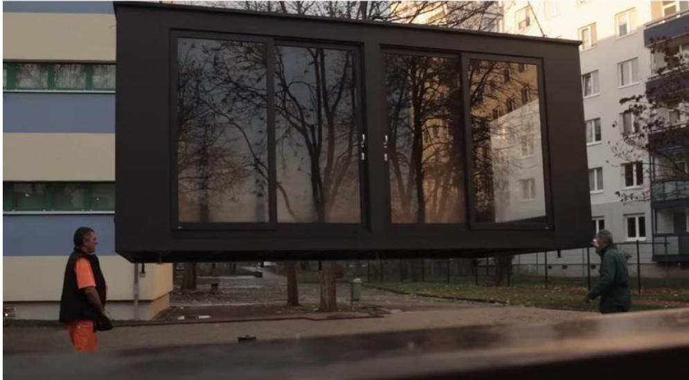
Das fliegende Klassenzimmer wurde vom Fraunhofer-Institut für Mikrostruktur von Werkstoffen und Systemen (IMWS) initiiert und ist ein innovativer Lernraum und Makerspace für Schüler\*innen. Er lässt sich mobil mittels eines Krans an verschiedenen Orten installieren und kann für Schulprojekte sowie außerschulische Projekte genutzt werden.
